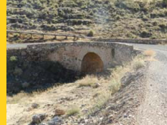
Puente Barranco de los Hornos
