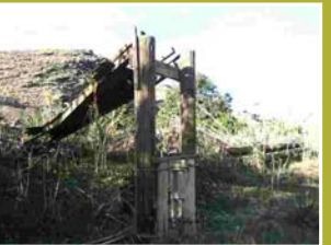
Antigua pasarela para cruzar el río
