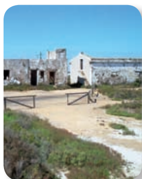
La casa salinera de Tres Amigos consta de dos edificios: uno corresponde a la zona doméstica donde se encontraba la casa en sí, el almacén y la cuadra, mientras que a la derecha tenemos el salón de los trabajadores.
